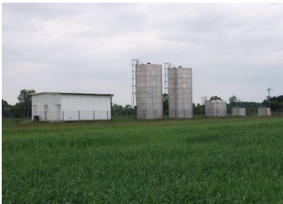
Stacja wodociągowa i ujęcie wody w miejscowości Purzec
