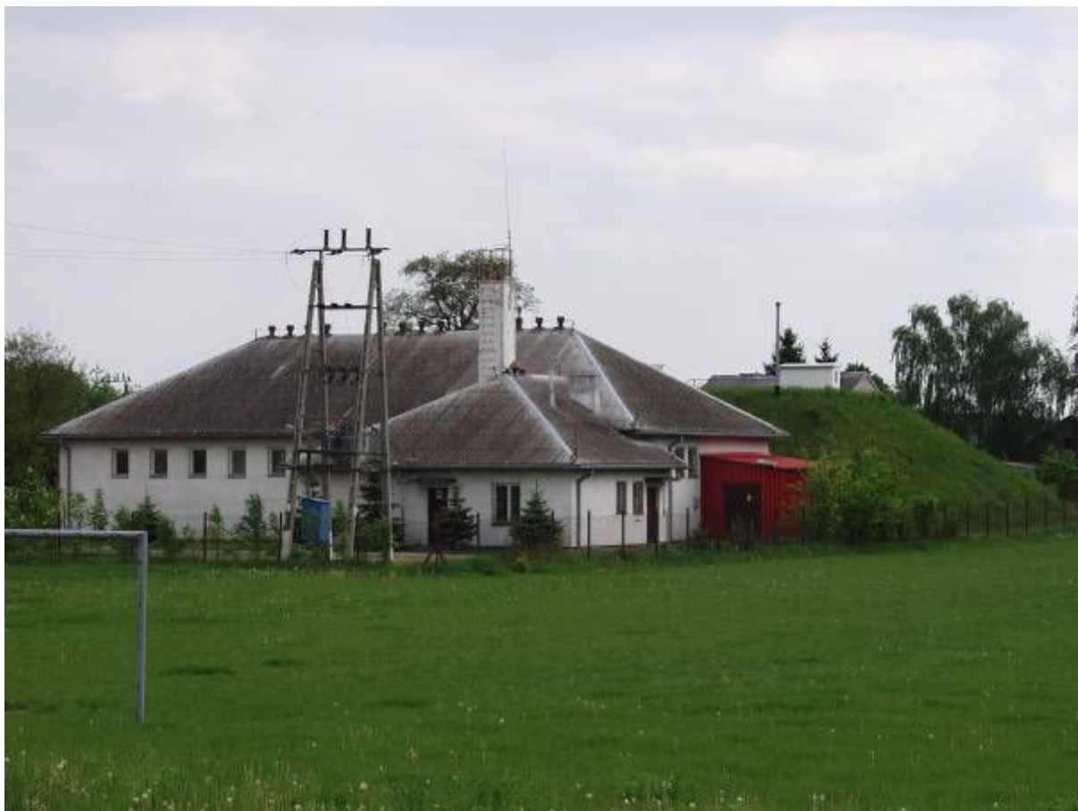
Stacja wodociągowa i ujęcie wody w miejscowości Ujrzanów
