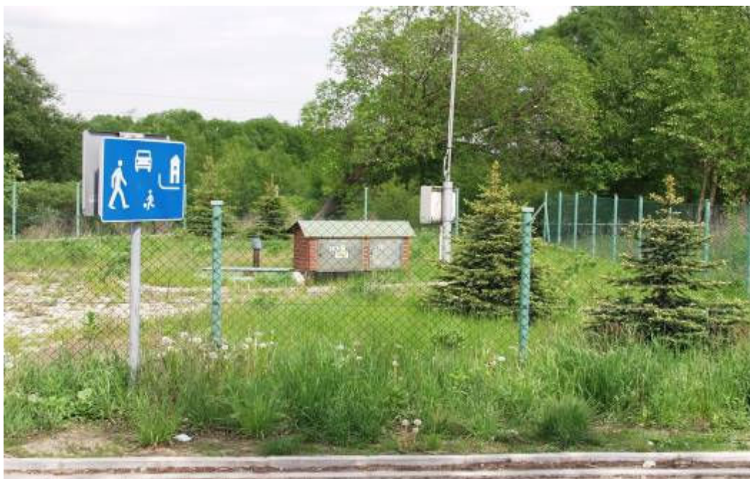
Przepompownia ścieków w miejscowości Żelków-Kolonia.
